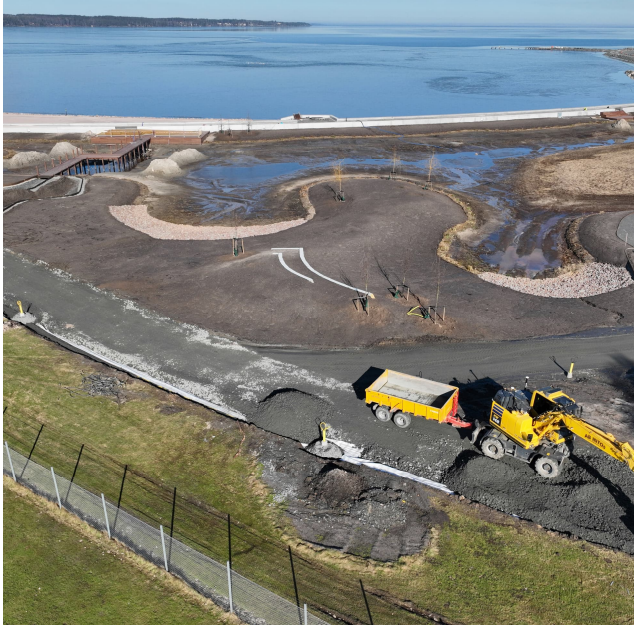
Noden montage av bärlinor för kommande trallyta
