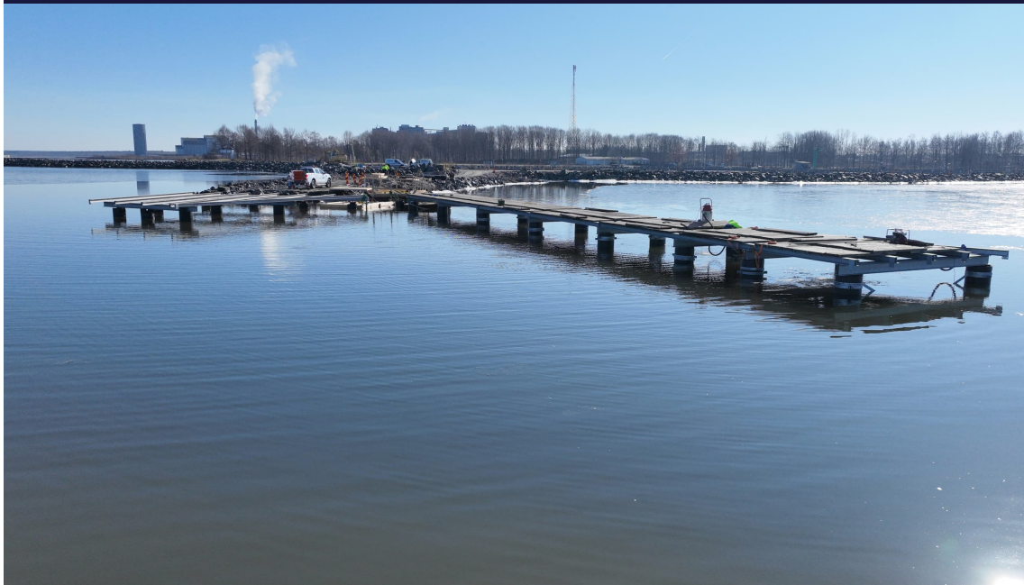
Just nu monterar vi stålverk och iskydd, samt schaktar bort arbetsvägen.
