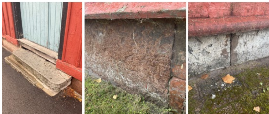
Exempel på ursprunglig kalkstenssockel och trappa. Vid omgestaltning av Esplanaden bör marken mot husen sänkas så att ursprungliga trappor och socklar blir återigen synliga.
