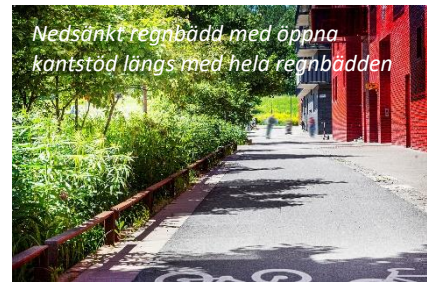
Nedsänkt regnbädd mellan gång- och cykelväg och körbana
