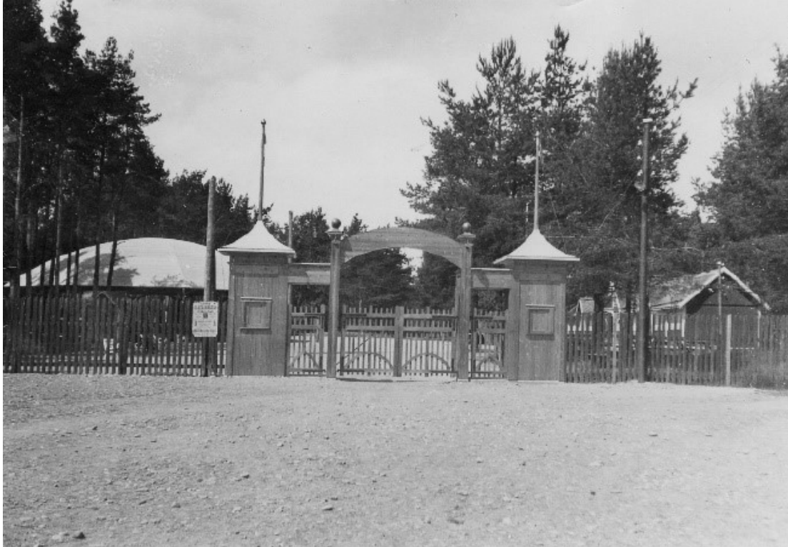
Figur 23 Ny entré. Rotundan har fått tak och fönster. Mittemot ligger en serveringsbyggnad (1937, Vänermuseet)
